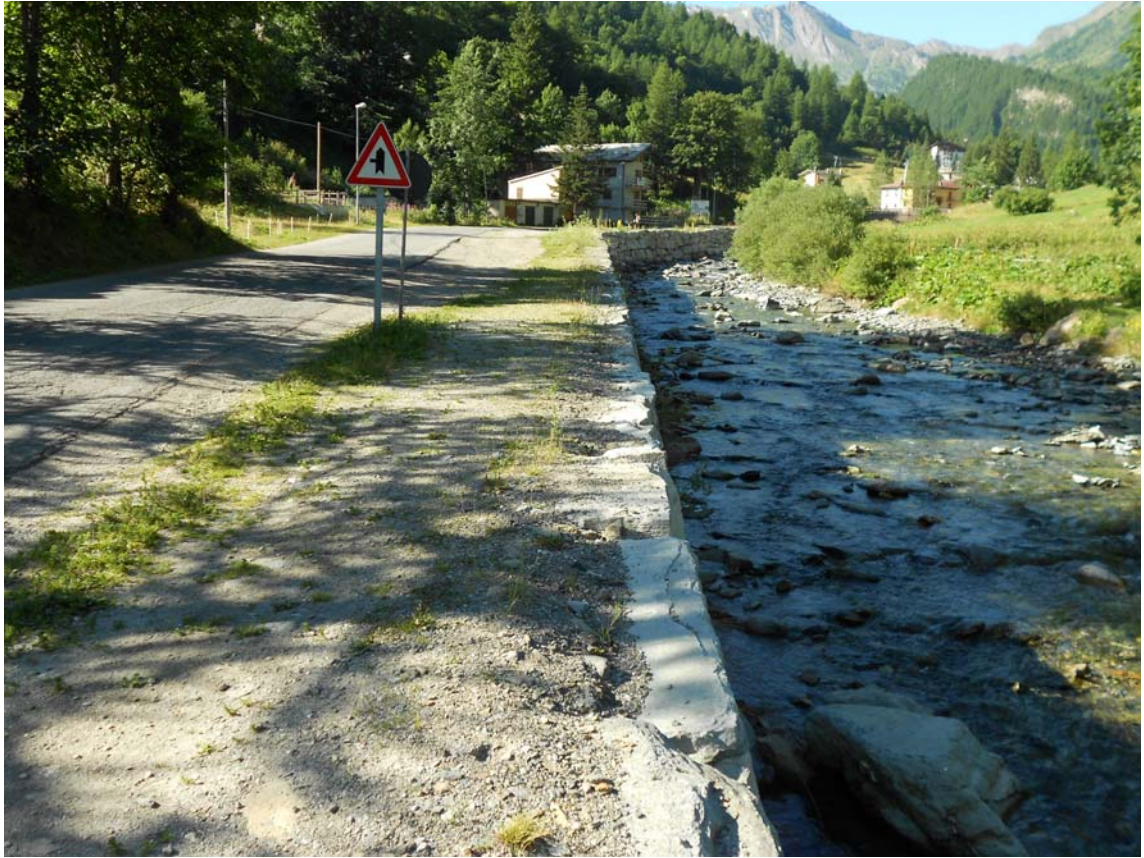
Foto 046 – Opera ZANEDS047. Veduta generale, ripresa da valle.
