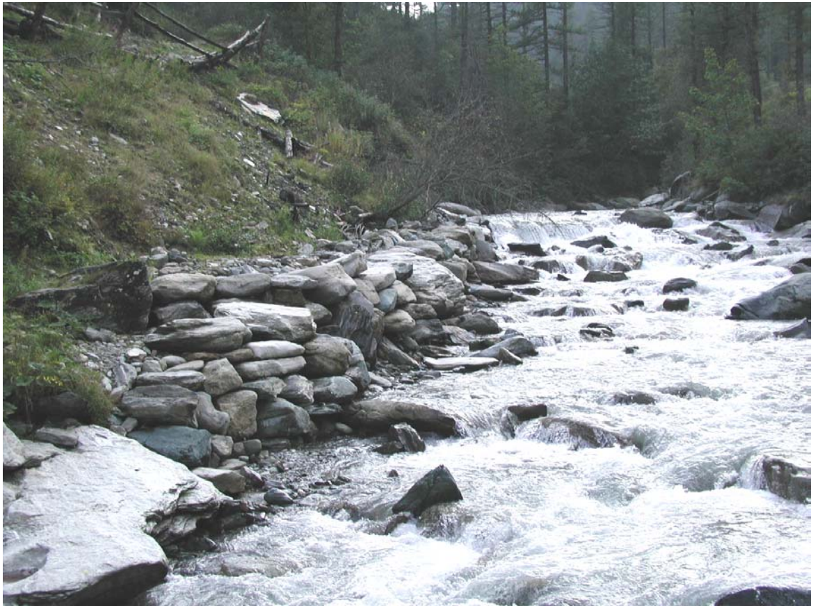
Foto 019 – Opera TREVDS019 . Dal ponte TREVPO011 verso monte.
