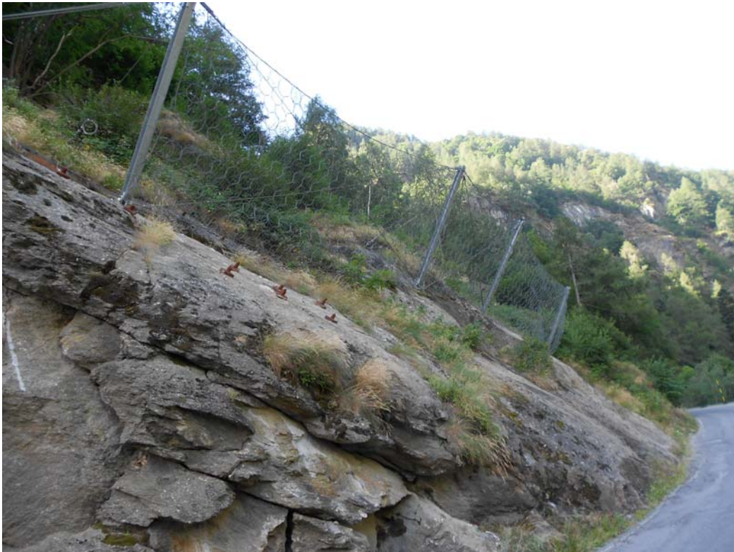
Foto 008 – Opera ZANEPR007 . Ripresa da valle lungo la S.P.
