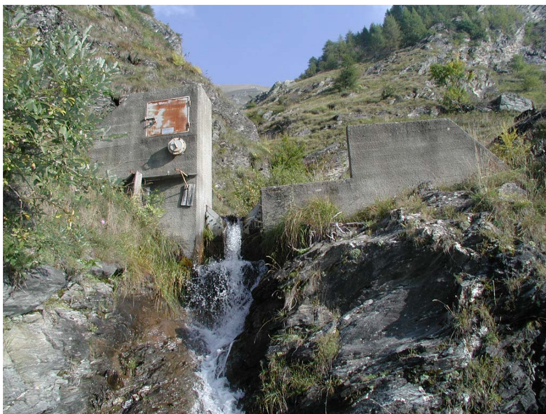
Foto 006 – Opera BATTBR011 . Da valle in corrispondenza del rio.
