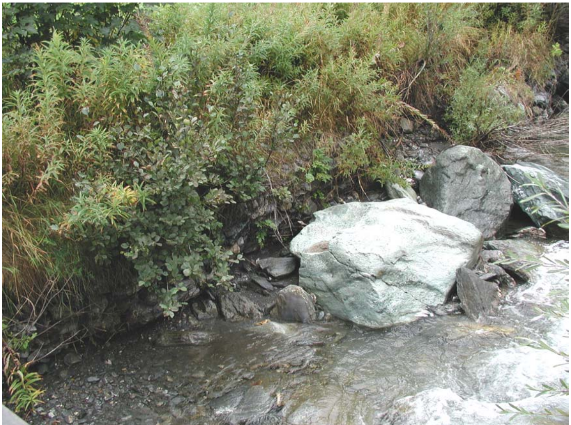
Foto 008 – Opera BATTDS008 . Dal ponte BATTPO003 verso monte.
