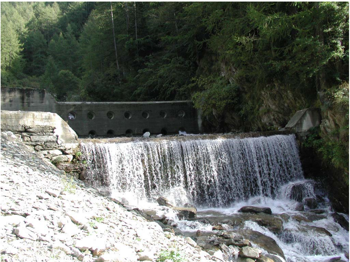
Foto 004 – Opere TREVR004 e BATTBR005 . Da valle sponda destra.
