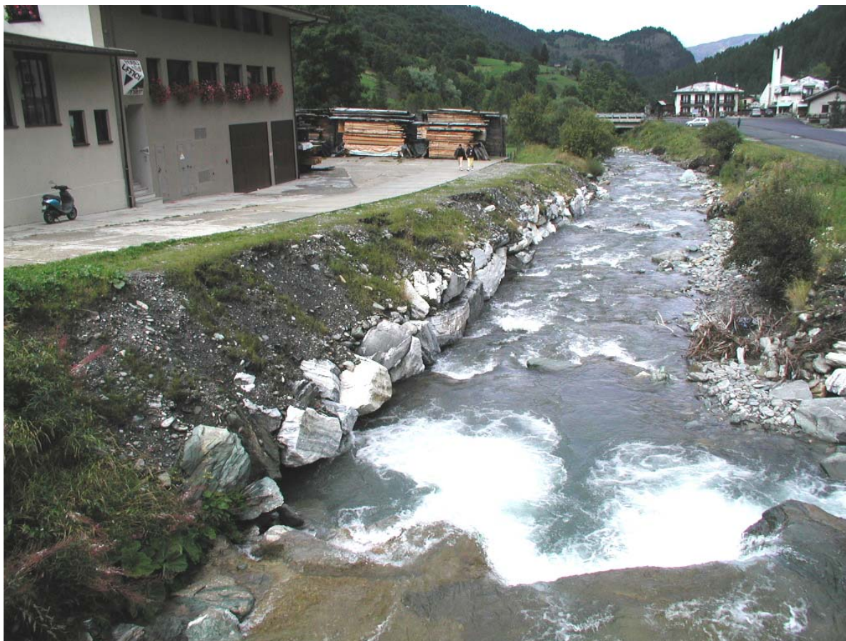
Foto 015 – Opera BATTDS015 . Dal ponte TREVPO007 verso valle.
